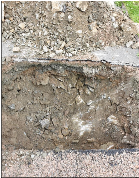
Figur 3. Sandiga fyllnadsmassor under asfalt på berg i PG4.
